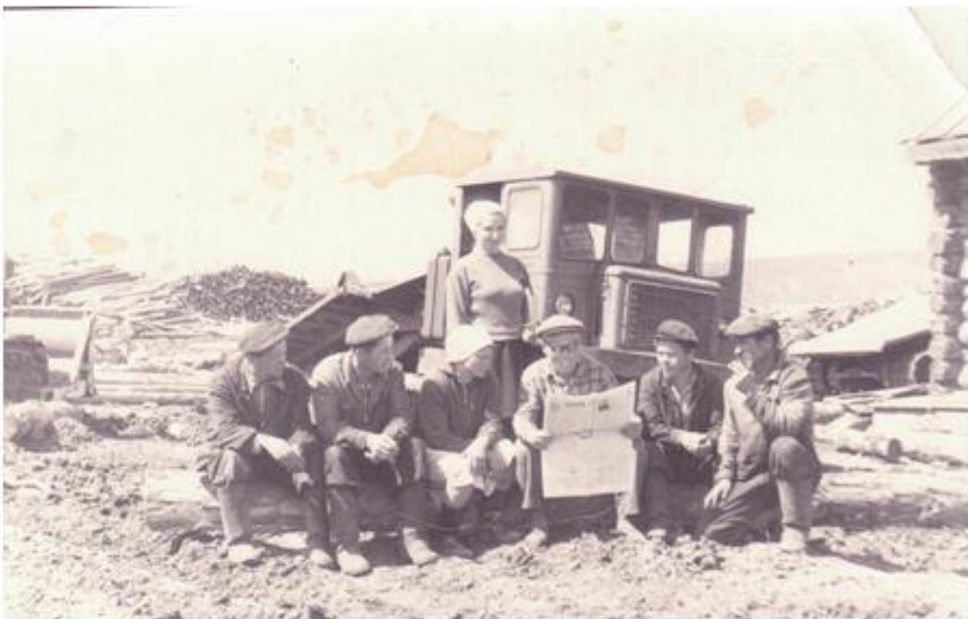
На фото: Л.П.Бортникова. Передвижка на лесозаготовительном участке, 1970-е г.
